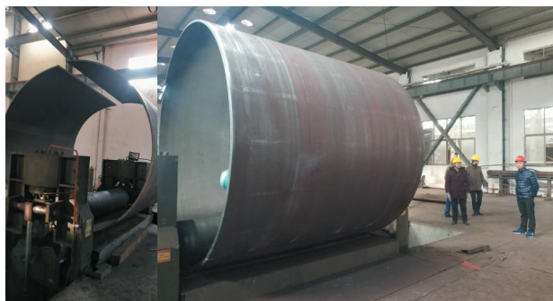
图 4.1 卷板机本项目大口径钢管卷管过程
